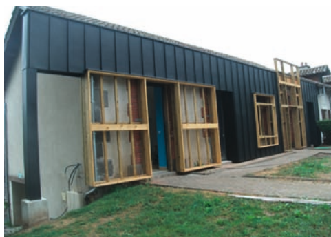
Réhabilitation de la maison des Associations en Maison d'Assistants Maternelles.
