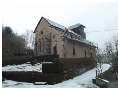
Réfection d'une partie du toit de l'église.
